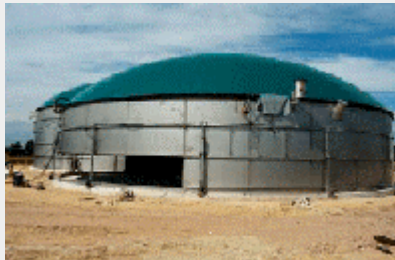
Un digesteur (Source : Solagro)
