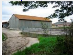
La fosse à lisier de la ferme
